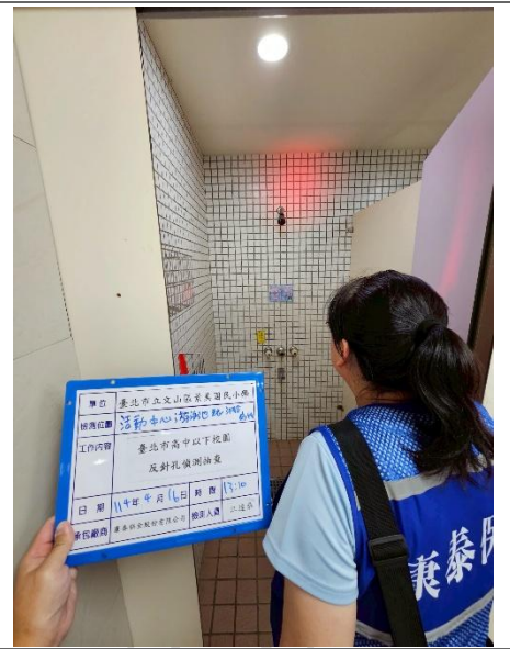
游泳池淋浴間
